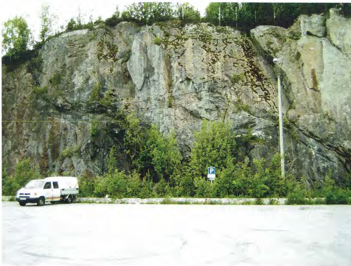
Fig. 3. Mørk amfibolitt som løper fra toppen av skjæringen bak bilen og nedover mot høyre til treklyngen midt i bildet. Videre mot høyre buler den ut og når en tykkelse på ca. 5 m før den faller ned mot høyre bildekant. På grensen mellom amfibolitt og øyegneis er det vanlig med oppsprekking og det kan ha foregått en forskyvning av bergartene langs slike sprekker.
