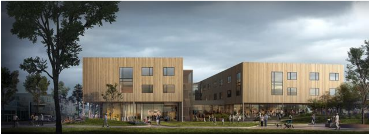
Det nye helse- og velferdssenteret sett frå Senior Plaza (nordsida)
