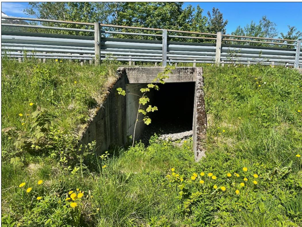
Figur 9: Flaumløp like nord for bruа på førre figur. Lysopninga er på om lag 2x2 m.
