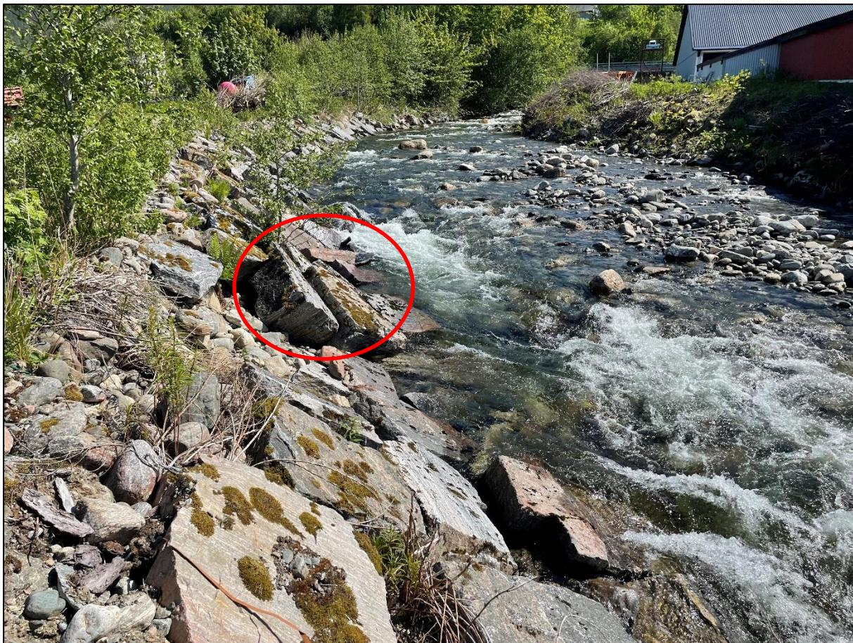
Figur 18: Erosjonssikring på venstre side av elva i nedre deler av elva. Enkelte stader er det mindre utglidingar og store holrom mellom blokkene.
