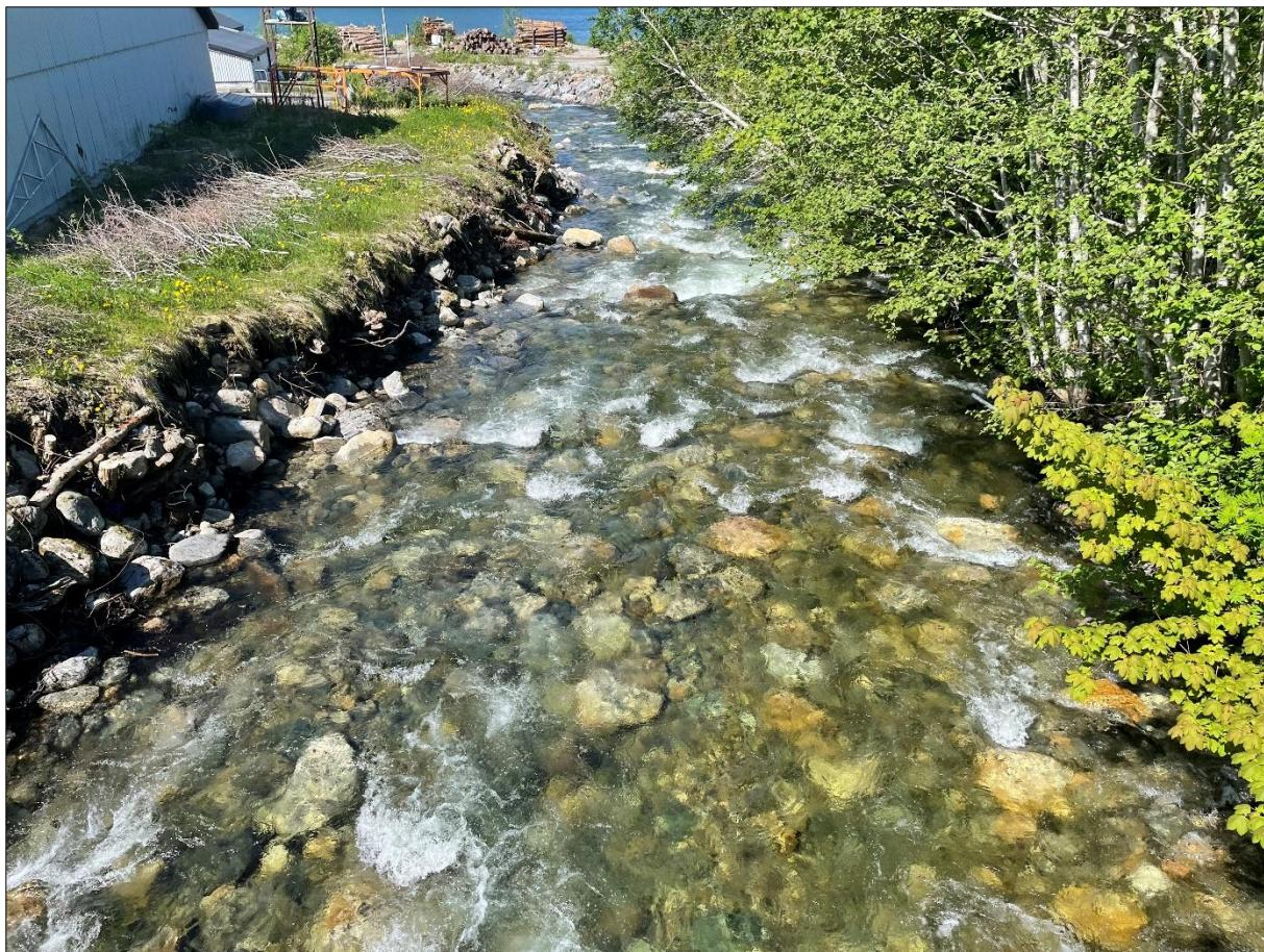
Figur 17: Bilete teke frå bruå langs Daugstadvegen. Det første stykket etter bruå er det ikke erosjonssikring langs elveløpet.
